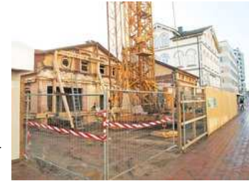
Die Baustelle in der Westerländer Strandstraße. Foto: Pierre Boom
