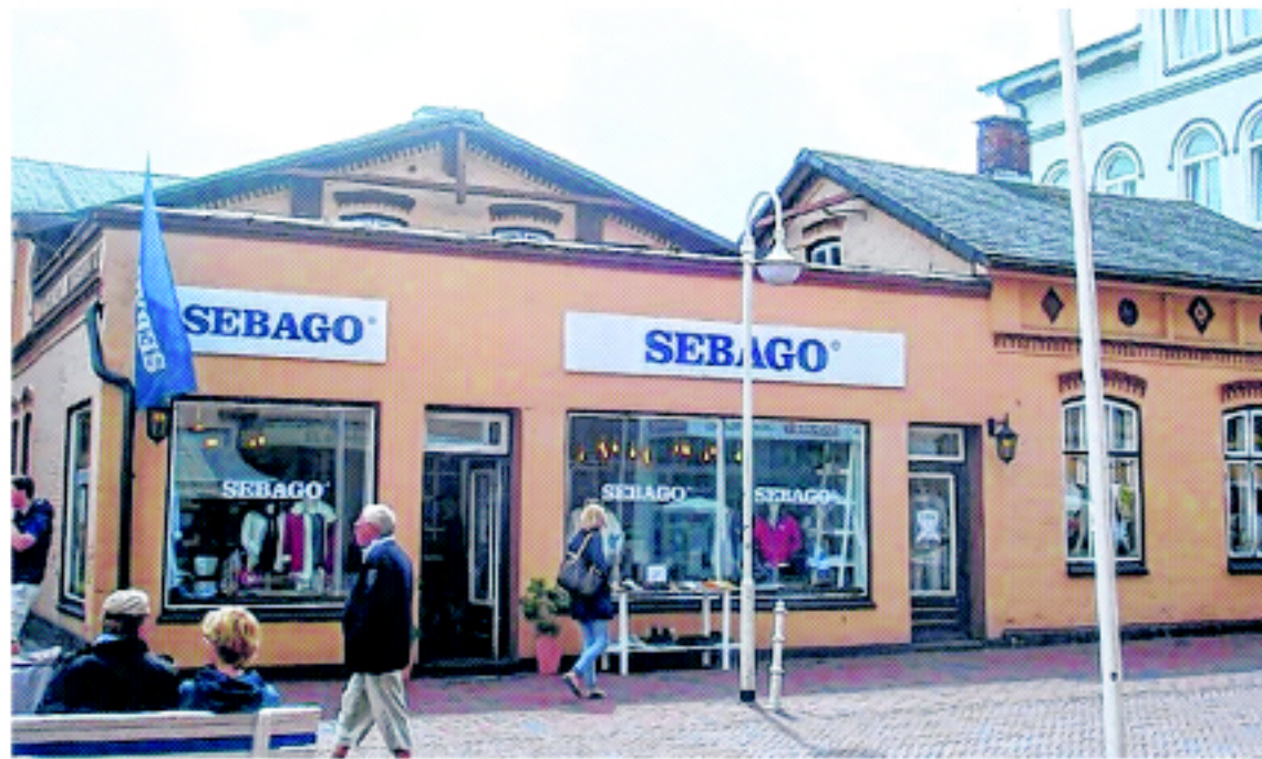
Der sanierungsbedürftige Altbau mit ockerfarbener Fassade.
